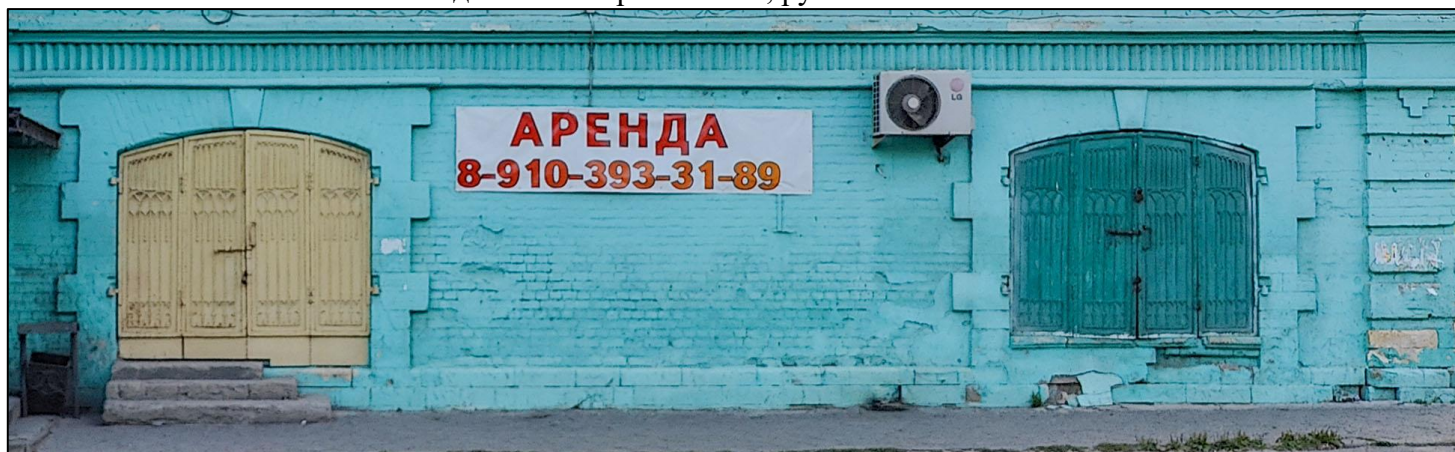
Междуэтажный пояс из угловой кирпичной кладки, оконные проемы с лучковыми перемычками с металлическими ставнями, декорированные каменными простыми наличниками с замковым камнем, рустованные лопатки.
