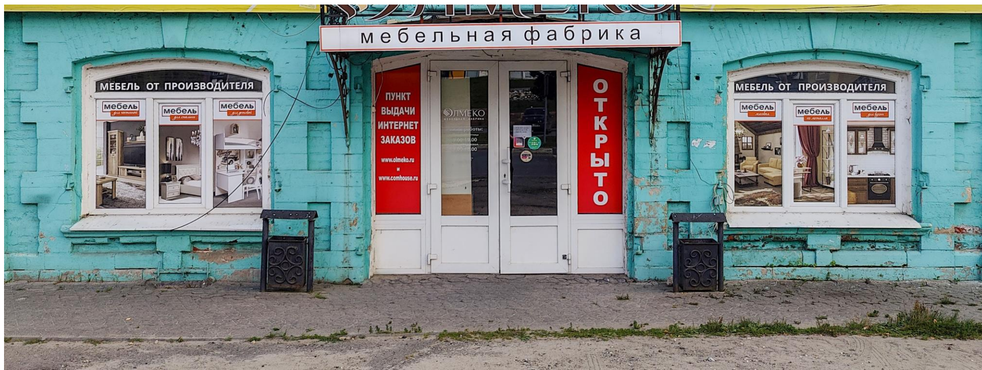
Оконные проемы с лучковыми перемычками, декорированные каменными простыми наличниками с замковым камнем, дверной проем с лучковой перемычкой, декорированный каменным простым наличником.
