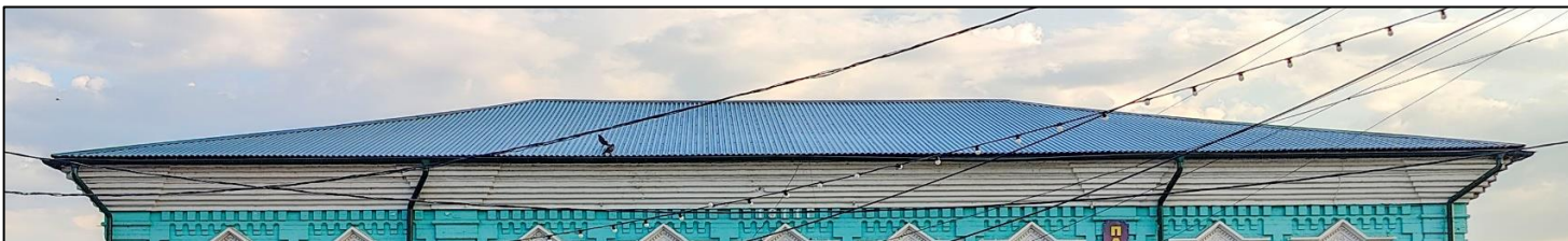
Вальмовая кровля, венчающий карниз, декорированный дентикулами.
